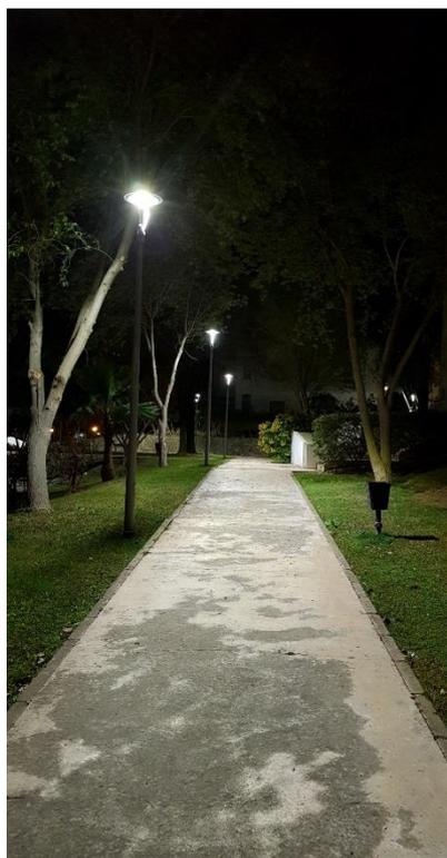
Respecto al alumbrado de parcelas, la Junta General de Macrocomunidad aprobó el cambio de farolas y columnas, por columnas de poliéster reforzado con fibra de vidrio con una garantía de fabricante de 15 años y luminarias leds con 10 años de garantía, con el incentivo del 30% del importe de la Junta de Andalucía.
