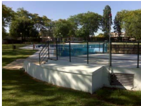
Instalación de depósitos de cloro en almacén exterior.
