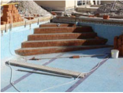
Construcción de escalera de obra de acceso a piscinas de adultos e infantil.
