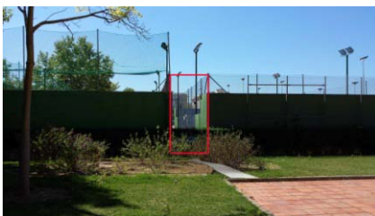
Construcción de pasillo de accesos a las pistas de padel desde zona de jardín.
