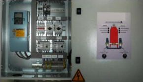
Instalación de nuevo cuadro eléctrico en la depuradora de la piscina con variadores de frecuencia e instalación de transductores de presión para las bombas.
